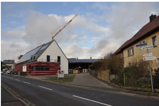
Abbildung 6: Dachdeckerbetrieb an der Grasholzstraße
